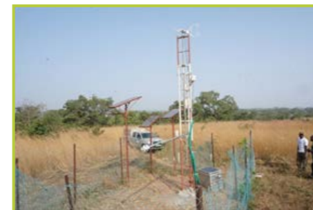
Remplacement du mat de la station de flux de Nalohou par un équipement beaucoup plus robuste
